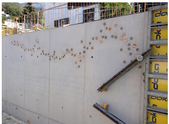
Der Entwurf wurde vor Ort direkt auf die Holzverschalung der Tiefgaragenmauer übertragen. In die Betonwand wurde eine Negativform aus Holz eingegossen. 2019, in der Fertigstellungsphase des Baues, werden die Schellen eingesetzt.
